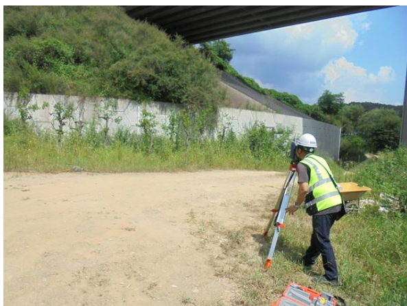
광파기를 이용한 측량 작업
